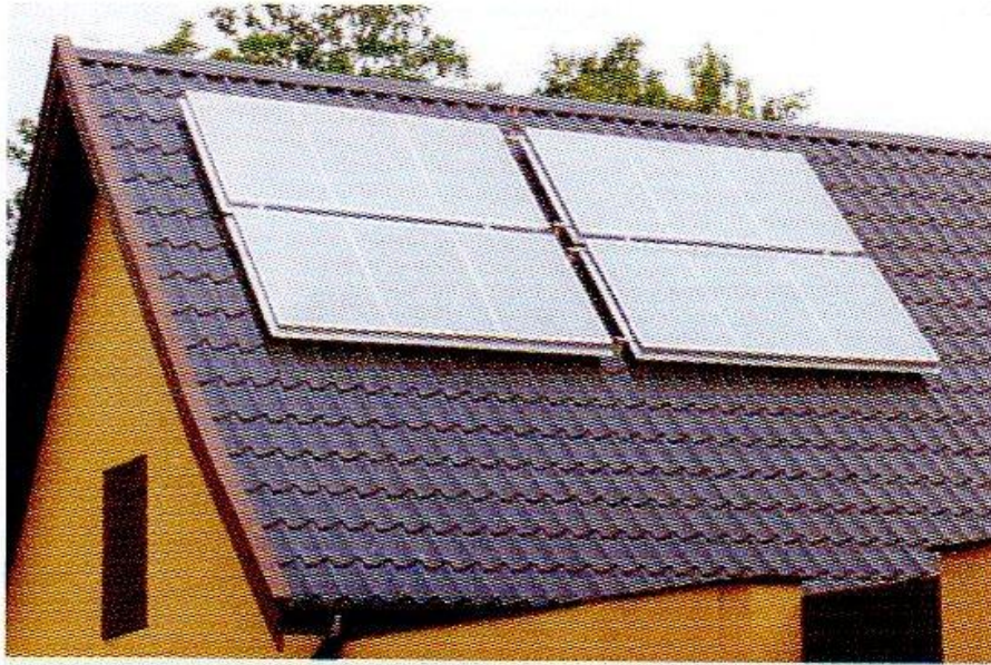
Painéis solares de aquecimento de água
